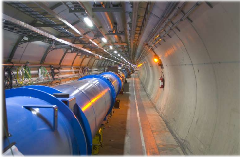
Illustration 21: Billede fra LHC tunnelen hvor tunnelens krumning anes
